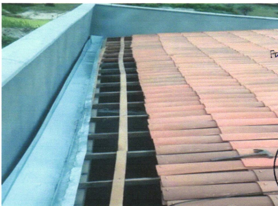
Foto 16 - CALHA EM CHAPA DE AÇO GALVANIZADO NÚMERO 24, DESENVOLVIMENTO DE 33 CM, INCLUSO TRANSPORTE VERTICAL. AF_07/2019
