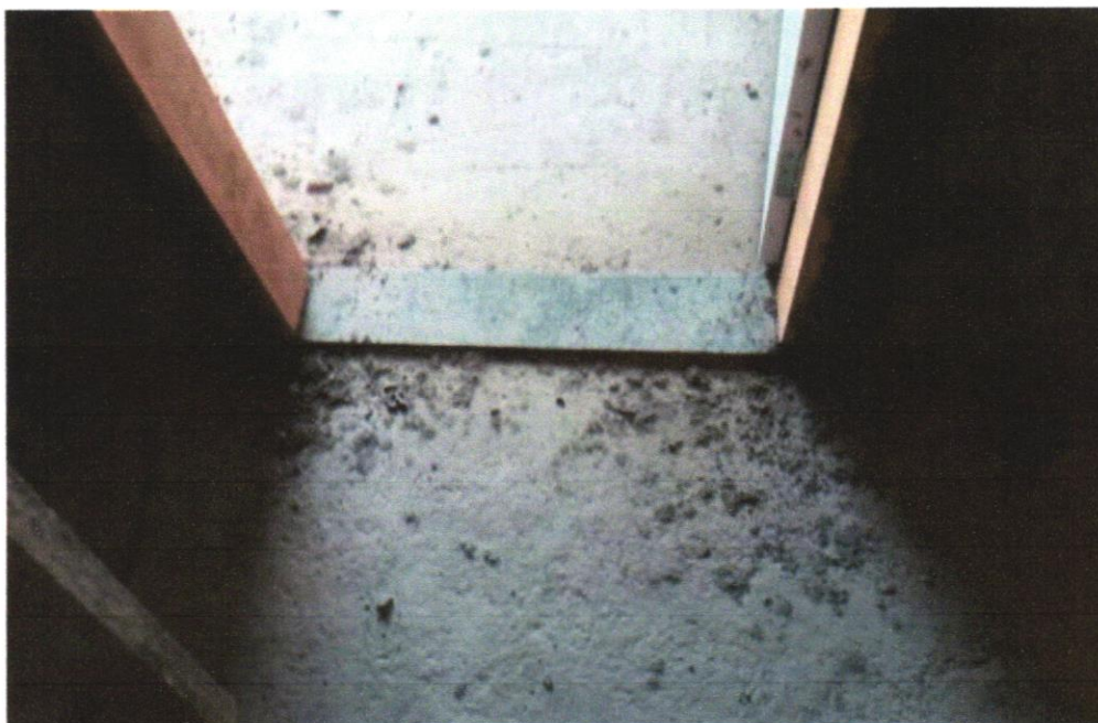
FOTO 02 – SOLEIRA EM GRANITO, LARGURA 15 CM, ESPESSURA 2,0 CM. AF_09/2020
