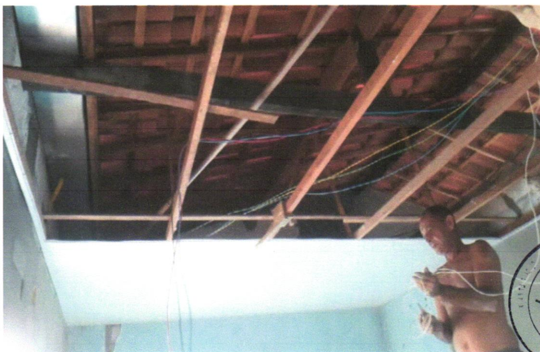
Foto 20- CABO DE COBRE FLEXÍVEL ISOLADO, 4 MM 2 , ANTI-CHAMA 0,6/1,0 KV, PARA CIRCUITOS TERMINAIS - FORNECIMENTO E INSTALAÇÃO. AF_12/2015
