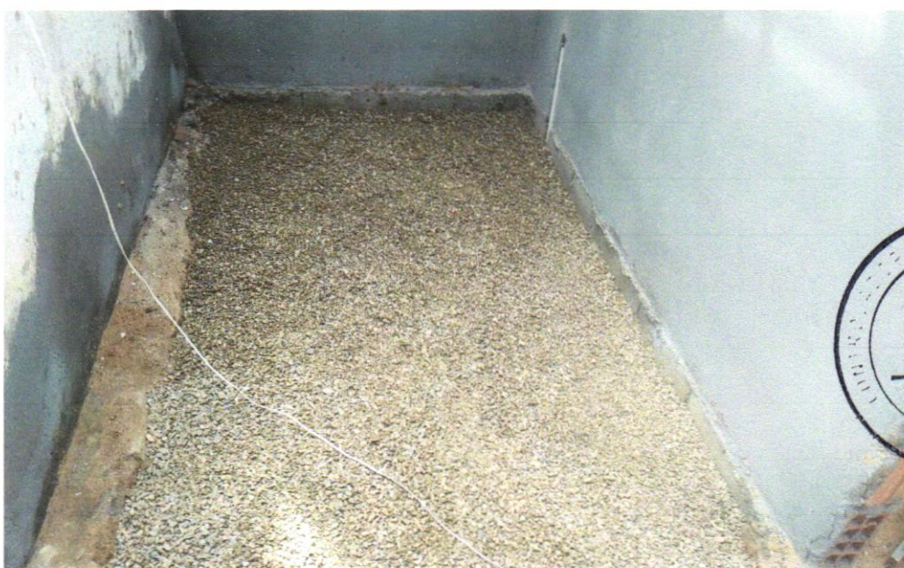
Foto 26- Lastro de brita graduada apiloada e=10cm
