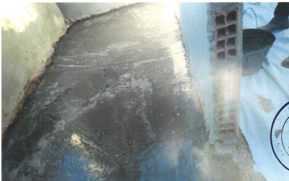
Foto 28- PISO EM CONCRETO 20 MPA PREPARO MECÂNICO, ESPESSURA 7CM. AF_09/2020
