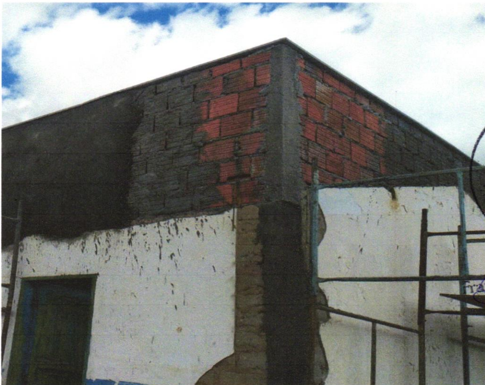
Foto 30- (COMPOSIÇÃO REPRESENTATIVA) EXECUÇÃO DE ESTRUTURAS DE CONCRETO ARMADO, PARA EDIFICAÇÃO HABITACIONAL UNIFAMILIAR TÉRREA (CASA EM EMPREENDIMENTOS), FCK = 25 MPA. AF_01/2017
