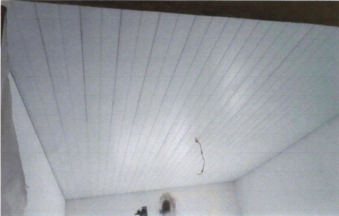
Foto 17- Forro de pvc, em régua de 10 ou 20 cm, aplicado, inclusive estrutura para fixação (perfis em PVC) marca Araforros ou similar, instalado - Rev 06_10/2021
