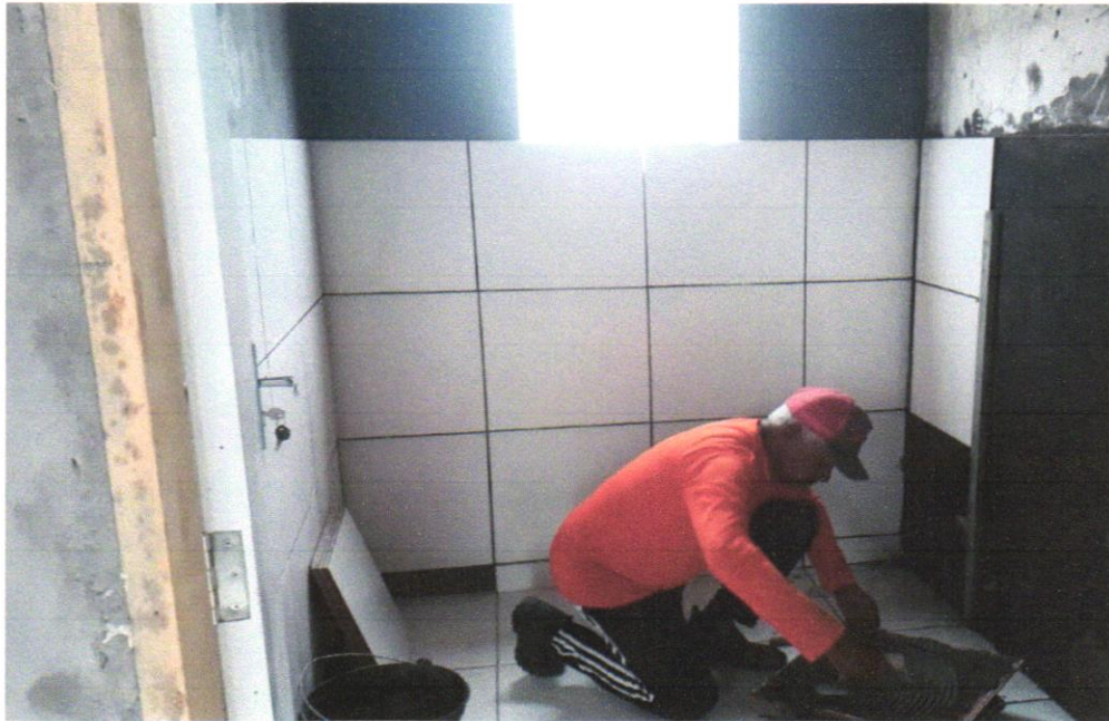
Foto 29 - REVESTIMENTO CERÂMICO PARA PAREDES INTERNAS COM PLACAS TIPO ESMALTADA EXTRA DE DIMENSÕES 33X45 CM APLICADAS EM AMBIENTES DE ÁREA MAIOR QUE 5 M 2 A MEIA ALTURA DAS PAREDES. AF_06/2014
