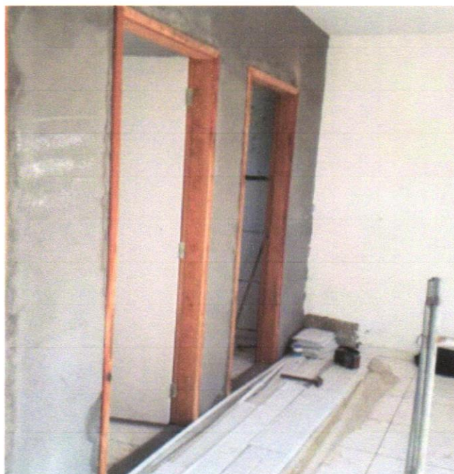
FOTO 06 – KIT DE PORTA-PRONTA DE MADEIRA EM ACABAMENTO MELAMÍNICO BRANCO, FOLHA LEVE OU MÉDIA, 80X210CM, EXCLUSIVE FECHADURA, FIXAÇÃO COM PREENCHIMENTO PARCIAL DE ESPUMA EXPANSIVA -FORNECIMENTO E INSTALAÇÃO. AF_12/2019
