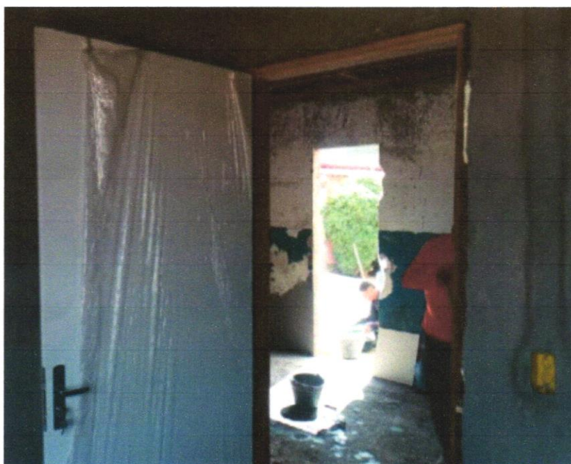
FOTO 05 – KIT DE PORTA-PRONTA DE MADEIRA EM ACABAMENTO MELAMÍNICO BRANCO, FOLHA LEVE OU MÉDIA, 90X210, EXCLUSIVE FECHADURA, FIXAÇÃO COM PREENCHIMENTO TOTAL DE ESPUMA EXPANSIVA - FORNECIMENTO E INSTALAÇÃO. AF_12/2019
