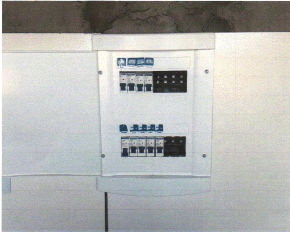
Foto 39 -Quadro de distribuição de embutir, em resina termoplástica, para até 16 disjuntores, com barramento, padrão DIN, exclusive disjuntores
