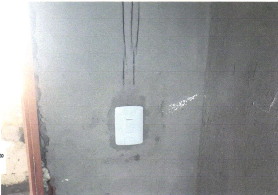
Foto 32- INTERRUPTOR SIMPLES (1 MÓDULO), 10A/250V, INCLUINDO SUPORTE E PLACA - FORNECIMENTO E INSTALAÇÃO. AF_12/2015
